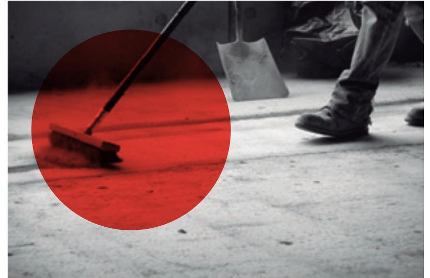
**Mantener limpias las zonas de trabajo y de paso, así como las casetas de obra, es otro factor esencial para evitar caídas, golpes o bloqueos en los desplazamientos por la obra y en los accesos a medios auxiliares.**
